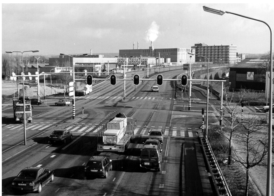
Foto 2 Kruispunt Via- ductweg/Noor- derbrug/ W.Alexanderweg: Reductie ver- keersongevallen door verhoging verlichtings- niveau van de openbare verlichting en verkeersregel- installatie
